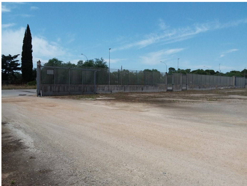
Figura 3- Recinzione frontestrada esistente
