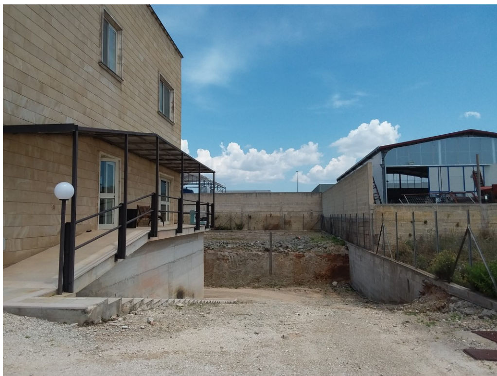
Figura 4- Rampa di accesso al piano interrato retrostante al Fabbricato
