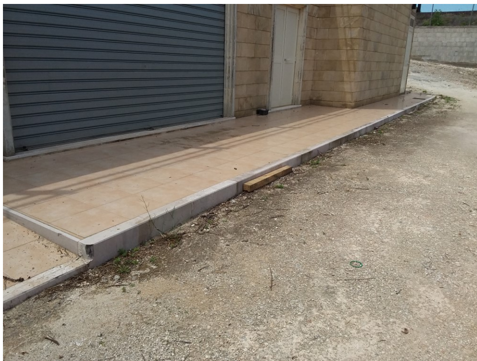
Figura 7 -Porzione di marciapiede retrostante da demolire al posto del quale verrà realizzata la rampa di accesso al garage
