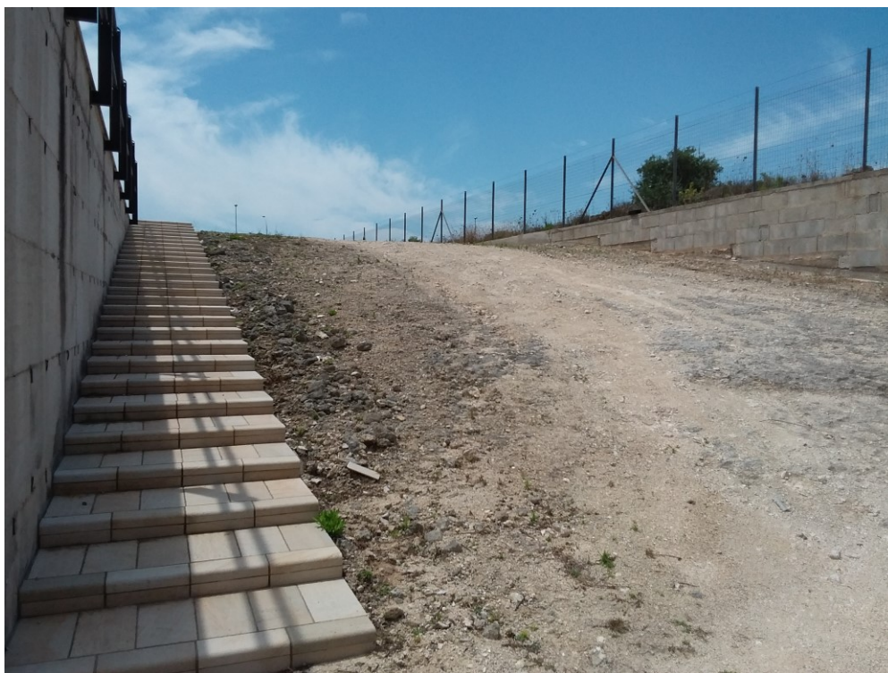
Figura 8 - Rampa n. 2 di accesso al piano sottoposto
