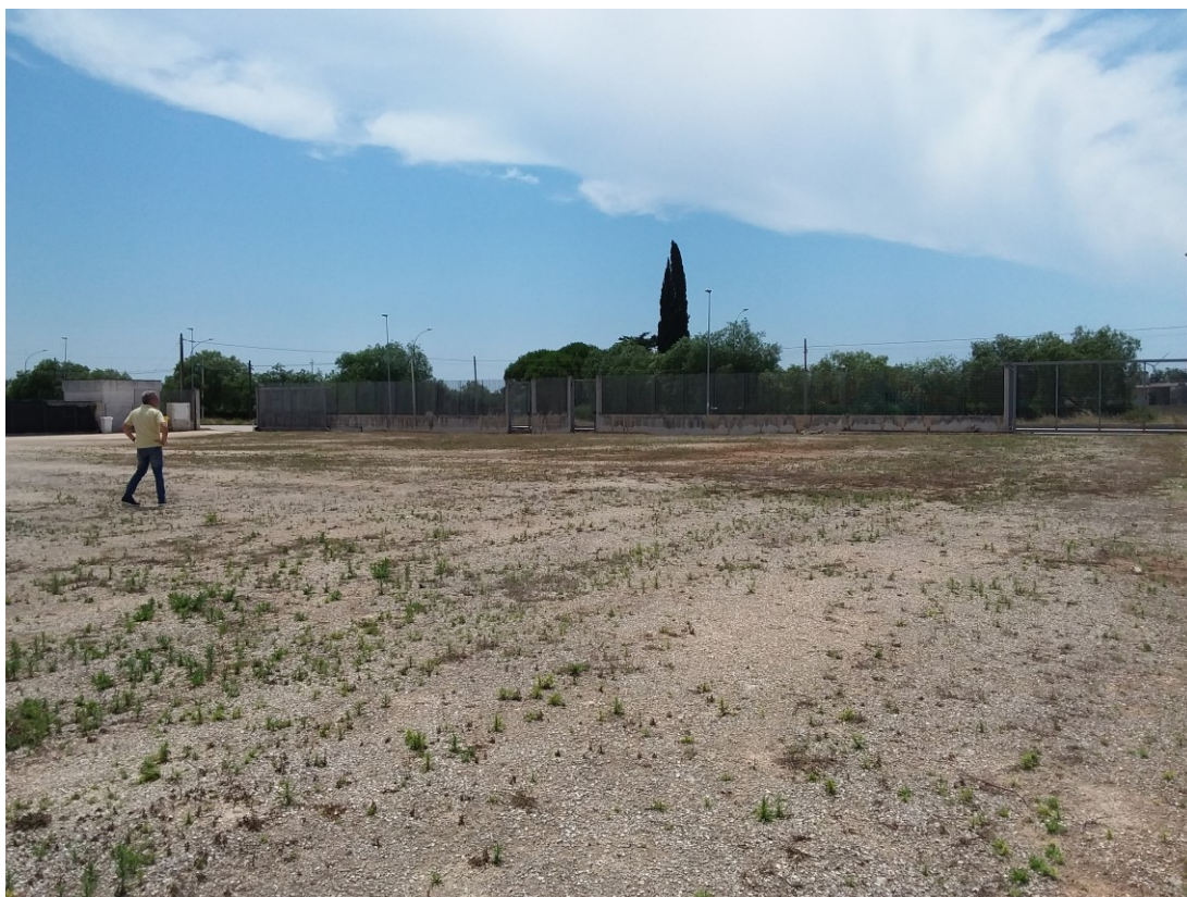
Figura 9 - Piazzale d'ingresso oggetto d'intervento di ultimazione e finitura
